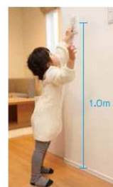
《高さ1mのスイッチ》
